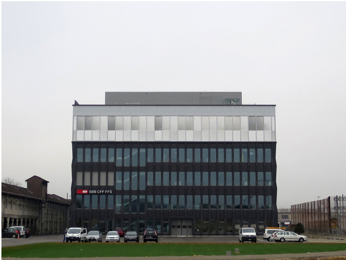
Abbildung 1: Betriebszentrale Mitte in Olten. Im Obergeschoss befindet sich der Kommandoraum.
