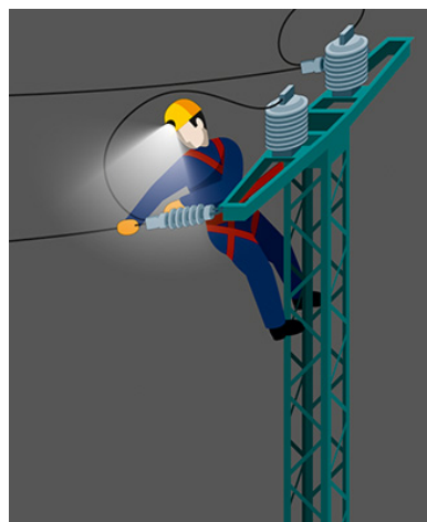
Abbildung 1: Arbeiten am Mastkopf im freien Feld mit einer Stirnleuchte (Jörg Block/BG ETEM).
